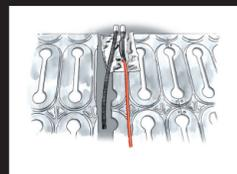
7) Vérifiez que les plaques ne soient pas recouvertes de copeaux de métal. Si c'est le cas, aspirez-les pour éviter tout dommage sur le câble.
