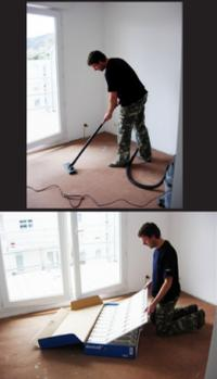
2) Disposez les plaques isolantes du système Devicell Dry.
