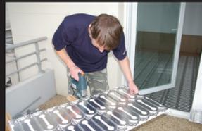
4) Verrouillez les plaques les unes aux autres avec les attaches, incluses dans le kit.
