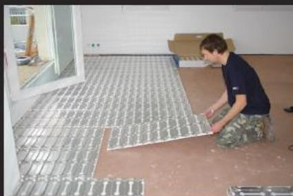
3) Les plaques Devicell Dry doivent recouvrir l'entière surface de la pièce. Ajustez les plaques Devicell Dry aux angles, en utilisant une scie électrique standard.
