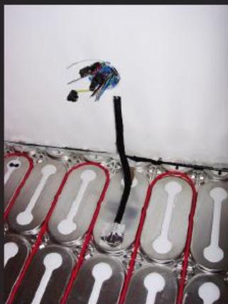
6) Recouvrez le tuyau flexible avec le boîtier de sonde fourni, en collant celui-ci ou en le vissant au plancher. Ensuite, poussez le câble de la sonde du thermostat vers le sol, à travers le tuyau flexible.
