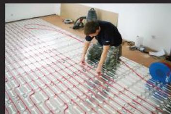
Installez le câble chauffant, en pressant délicatement le câble dans les rainures.
