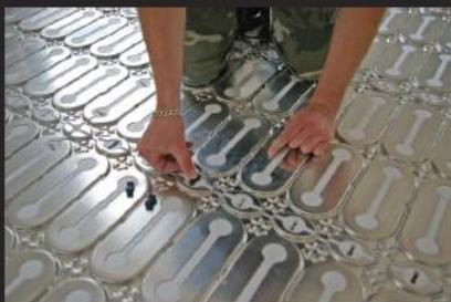
5) Faites une saillie dans la plaque Isolante Devicell Dry pour permettre à la sonde de dalle d'atteindre le sol. Puis placez-y le tuyau flexible du thermostat. Repoussez ensuite la liaison froide du câble du sol vers le mur, jusqu'à ce qu'elle atteigne le thermostat.
