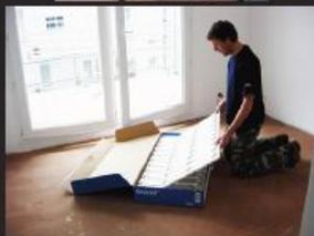
2) Disposez les plaques isolantes du système Devicell Dry.
